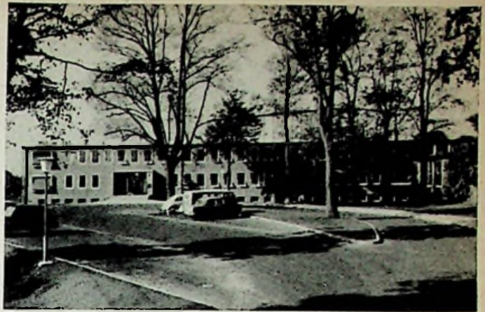
Bild 1. Front des neuen Fernsehstudios des NWDR in Hamburg-Lokstedt
